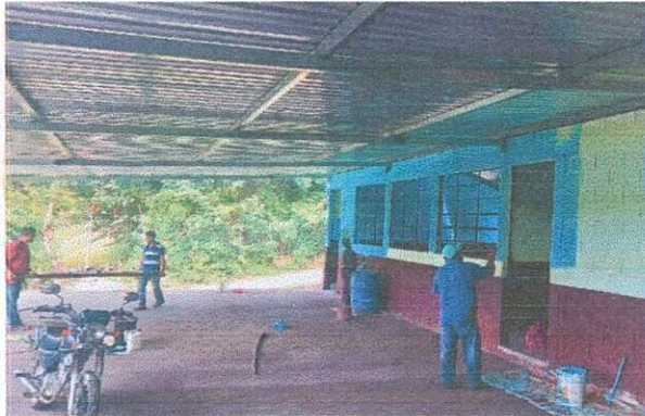
Foto 7: Pintura para la fachada del aula, dirección, bodega y baños.
