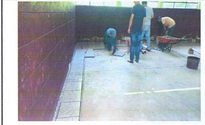
Foto 2: Mejoramiento y reparación de piso de aula, patio, dirección y bodega.
